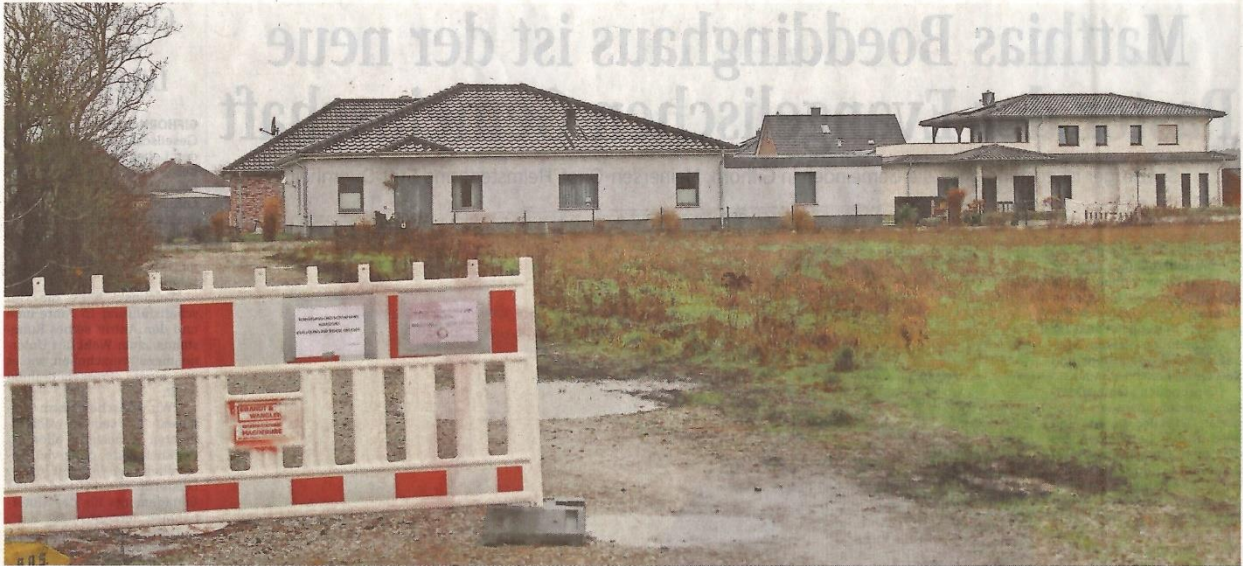
„Vorankommen“: Der B-Plan „Kälberanger III“ liegt trotz Corona bei der Gemeinde aus – und ein paar Bauplätze sind noch zu haben.
