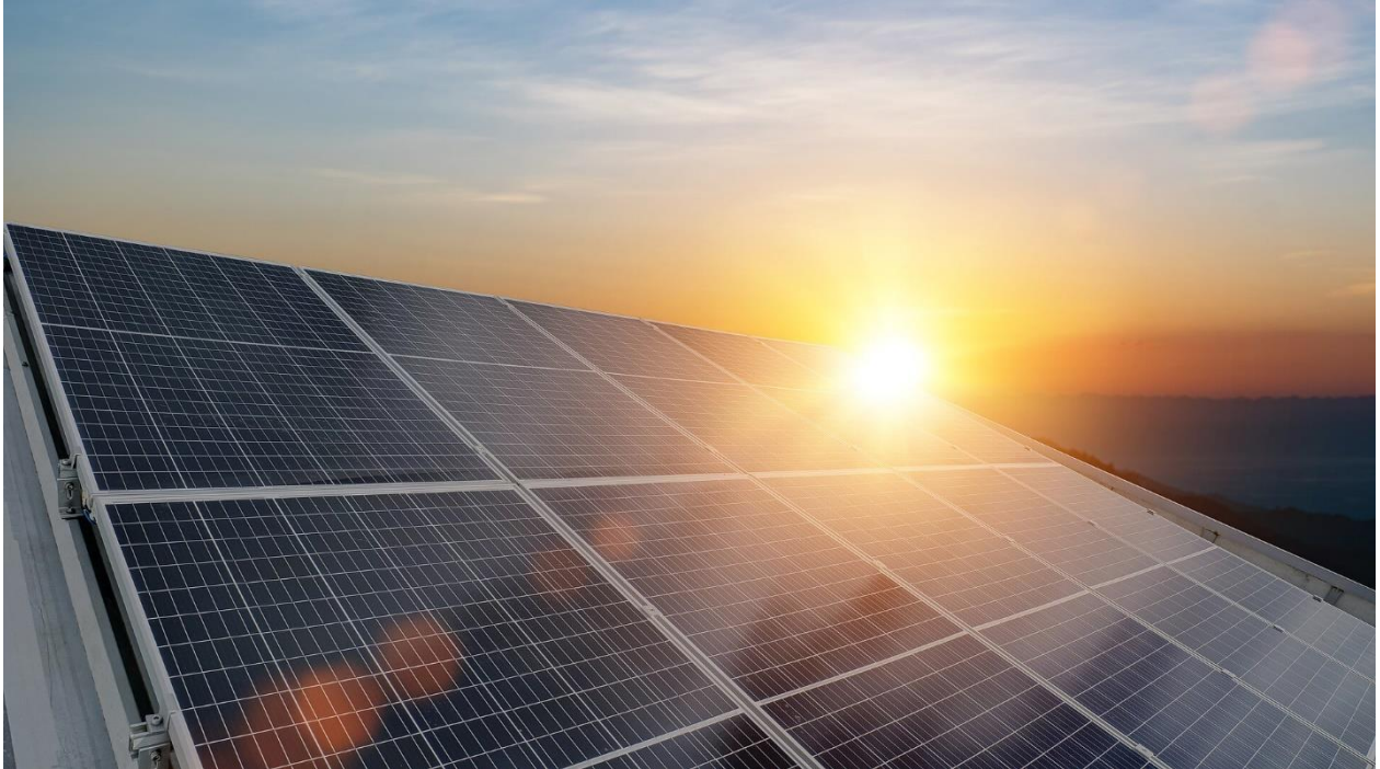
Abbildung 15 - Sonnenuntergang hinter einer Modulreihe - Quelle: https://www.innotech-safety.com/fileadmin/_processed_/c/4/csm_5_Tipps_rund_um_Ihre_PV-Anlage_am_Dach-Header_356649df9b.jpg
