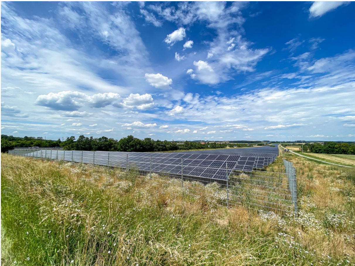
Abb. 7: Beispiel Einfriedung einer PV-FFA (Foto: EE-Plan, April 2020)
